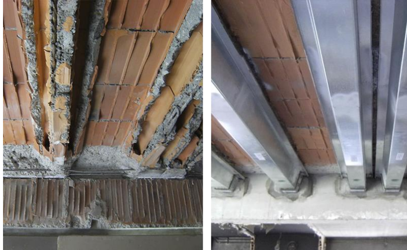
Imatge 7: Sistema de reforç Noubau
