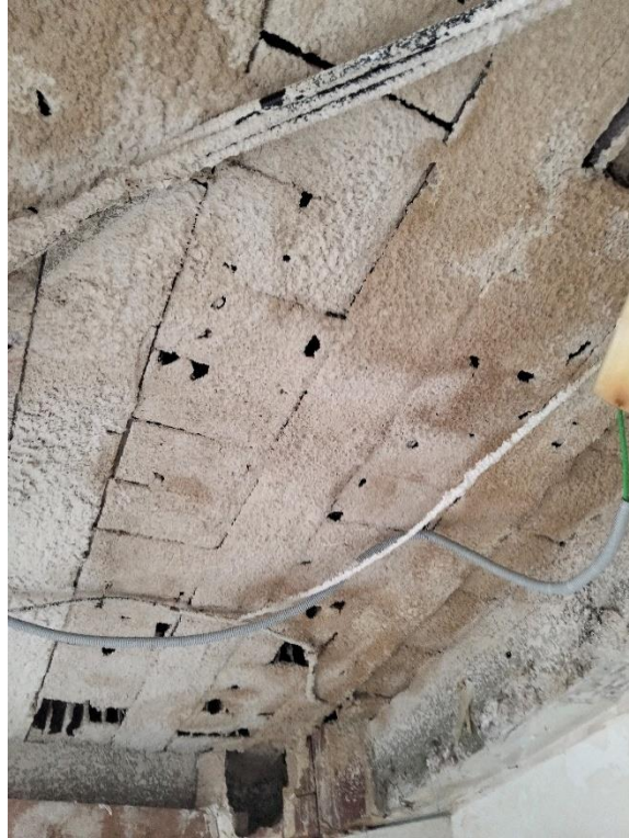
Imatge 2: Forjat bigueta ceràmica armada
